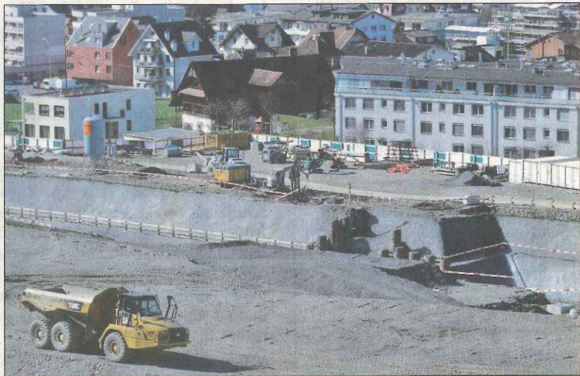
Bei der Schürmatt wurde der Voreinschnitt Ende März abgeschlossen. Foto: fab
