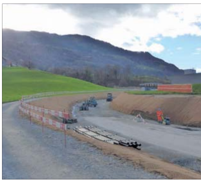
Offener Einschnitt beim Luterbach kurz vor dem Einbau der ersten Belagsschicht.
